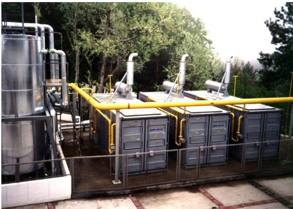
Рис. 2. Блочно-модульные КУ высокой заводской готовности производства ELTECO (Словакия)
