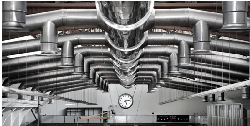
Рис. 3. Общеобменная система вентиляции
