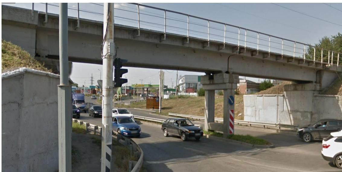
Рис. 3. Железнодорожный мост, создающий препятствие для движения автотранспорта с крупногабаритным грузом
