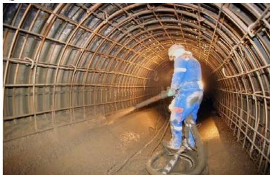
Рис. 1. Нанесение бетонной смеси методом торкретирования в туннеле
