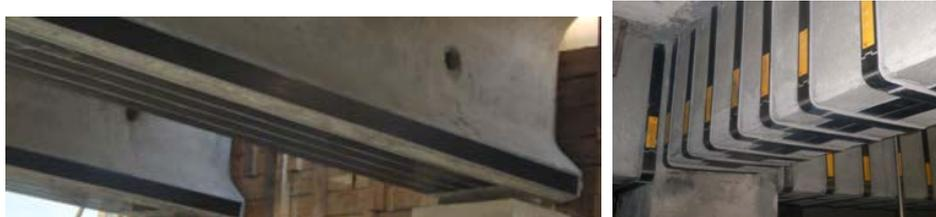
Рис. 3. Усиление конструкций углепластиковыми ламелями
