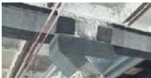
Рис. 2. Усиление конструкций тканями из углеволокна
