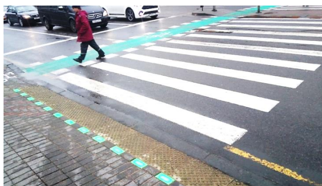
Рис. 3. Обустройство велосипедной дорожки вблизи пешеходного перехода
