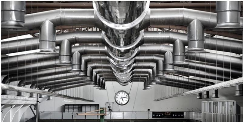
Рис. 3. Общеобменная система вентиляции
