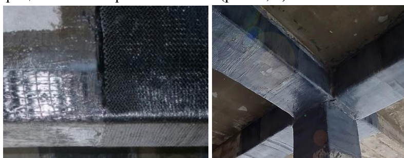
Рис. 2. Усиление железобетонных конструкций тканями из углеволокна
