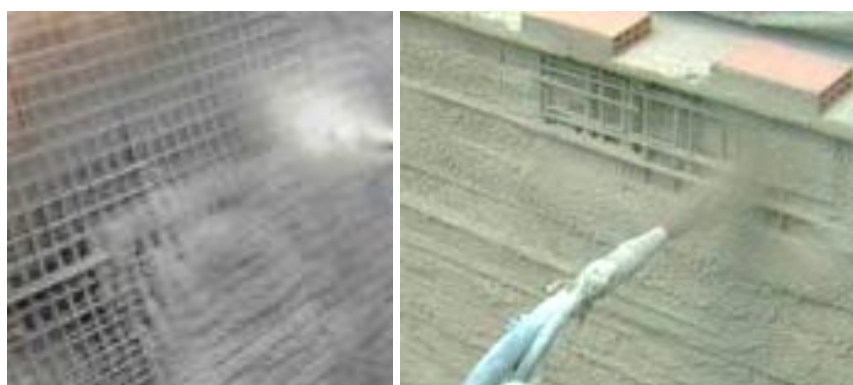
Рис. 5. Нанесение бетонной смеси методом торкретирования
