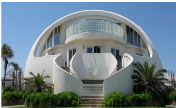
Рис. 4. Здание, построенное методом торкретирования
