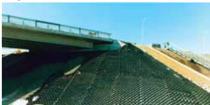
Рис. 4. Усиление грунта при строительстве мостового перехода с помощью георешеток
