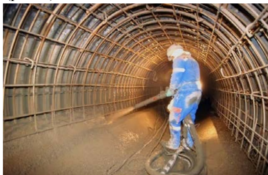
Рис. 1. Нанесение бетонной смеси методом торкретирования в туннеле
