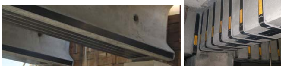
Рис. 3. Усиление конструкций углепластиковыми ламелями
