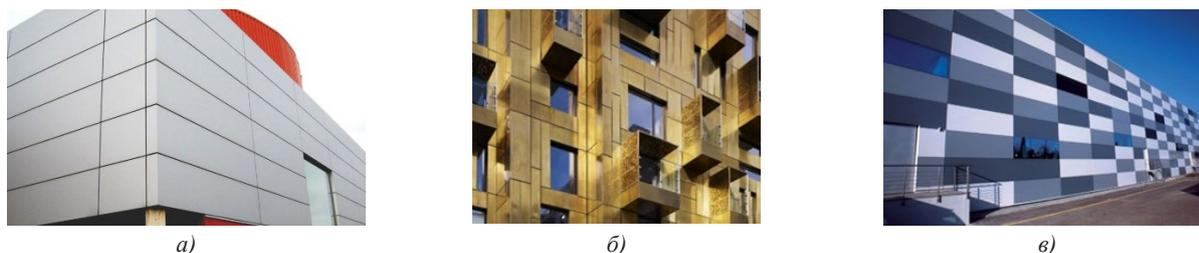
Рис. 1. Виды металлических облицовочных панелей: а — композитные алюминиевые; б — латунные; в — металлокерамические
