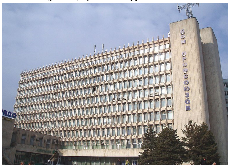
Рис. 1. Главный фасад Дома профсоюзов Ростова-на-Дону
