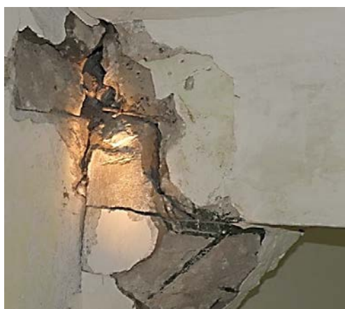
Рис. 3, 4. Отрыв закладных деталей стеновых панелей
