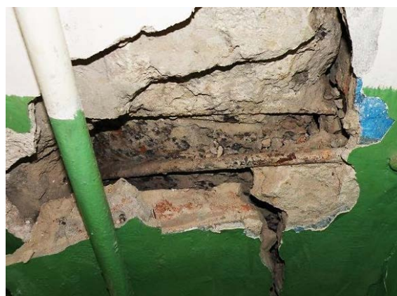
Рис. 3, 4. Отрыв закладных деталей стеновых панелей
