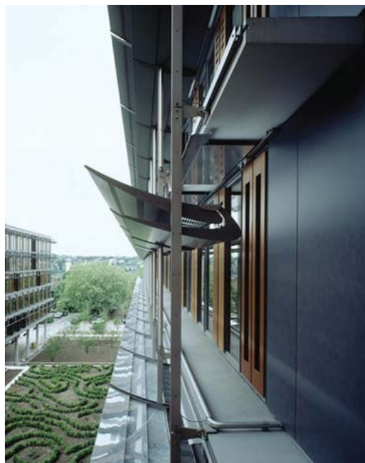
Рис. 1. Рефлекторная система дневного освещения
